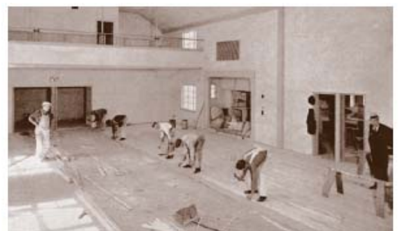
Высококачественное дощатое покрытие для пола тщательно укладывается в центре отдыха в Сан-Франциско. 30-е годы
